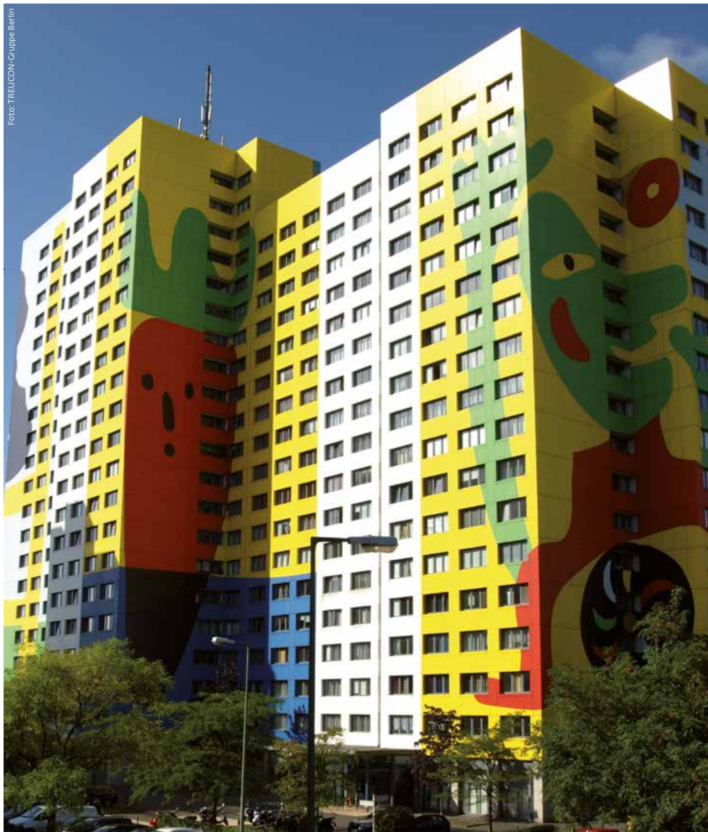
Das Plattenbau-Hochhaus „GUSTAVO“ wurde entkernt, modernisiert und instandgesetzt und 1999 an die HOWOGE übergeben
