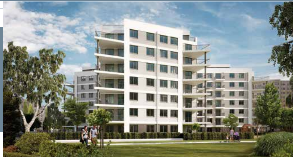
Das gemeinsame Neubauprojekt der des Projektentwicklers TREUCON Gruppe Berlin und Kondor Wessels, Flämingsstraße 70 in Berlin-Marzahn, wurde drei Monate vor dem Fertigstellungstermin an die HOWOGO Wohnungsbaugesellschaft übergeben
